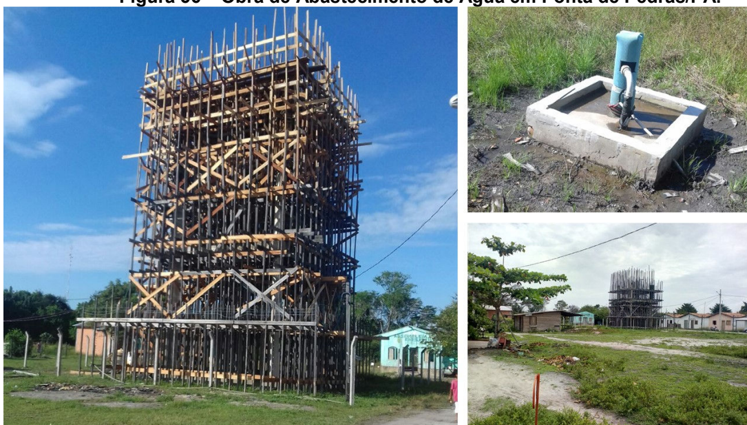
Obra de sistema de água na Vila Pedrolândia, Ponta de Pedras/PA. Fonte: Laboratório de Estudos das Cidades, 2018.
