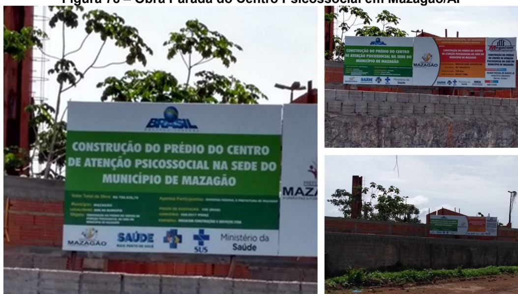
Figura 78 – Obra Parada do Centro Psicossocial em Mazagão/AP
