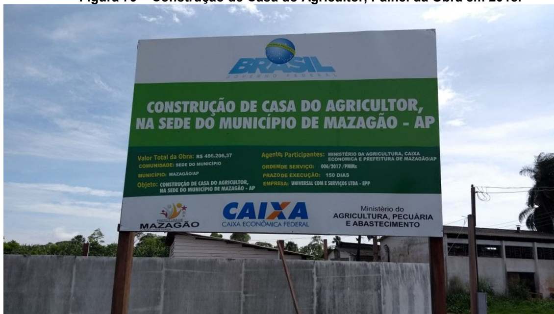
Figura 79 – Construção de Casa do Agricultor, Pannel da Obra em 2018.
