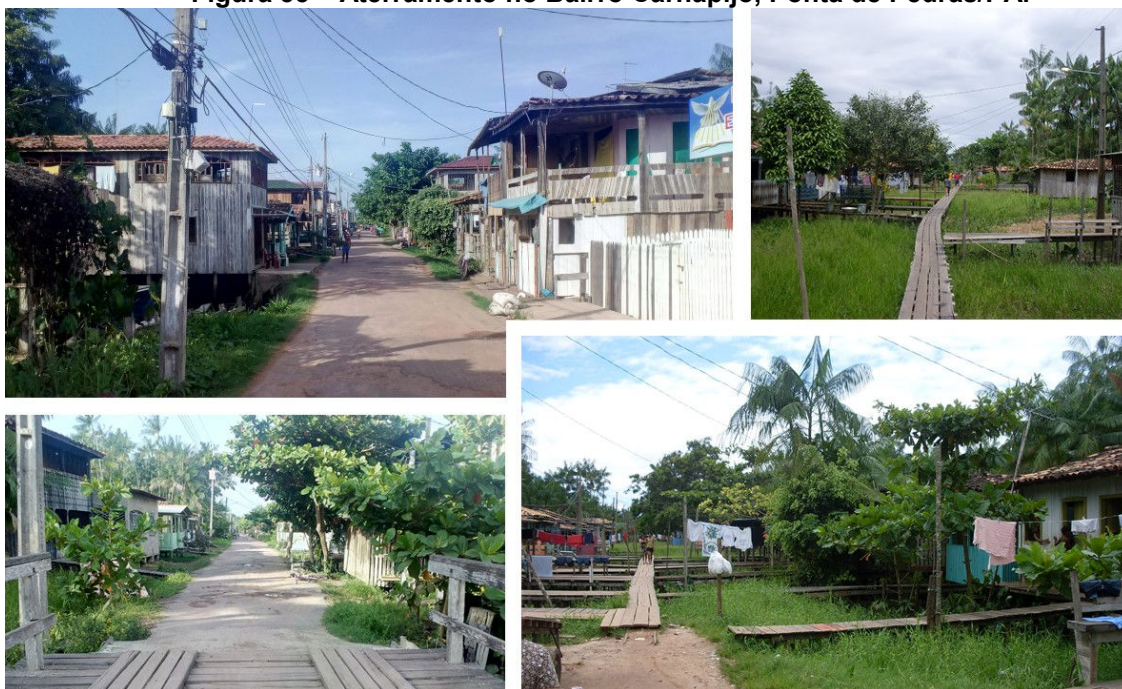
Figura 35 – Aterramento no Bairro Carnapijó, Ponta de Pedras/PA.
