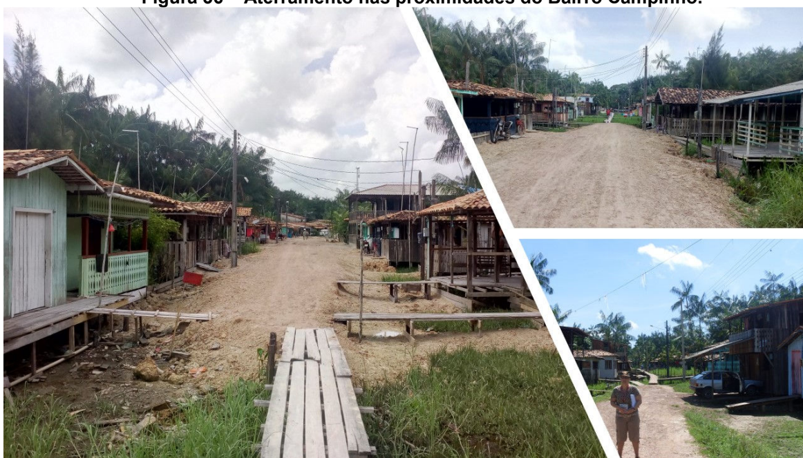
Figura 36 – Aterramento nas proximidades do Bairro Campinho.
