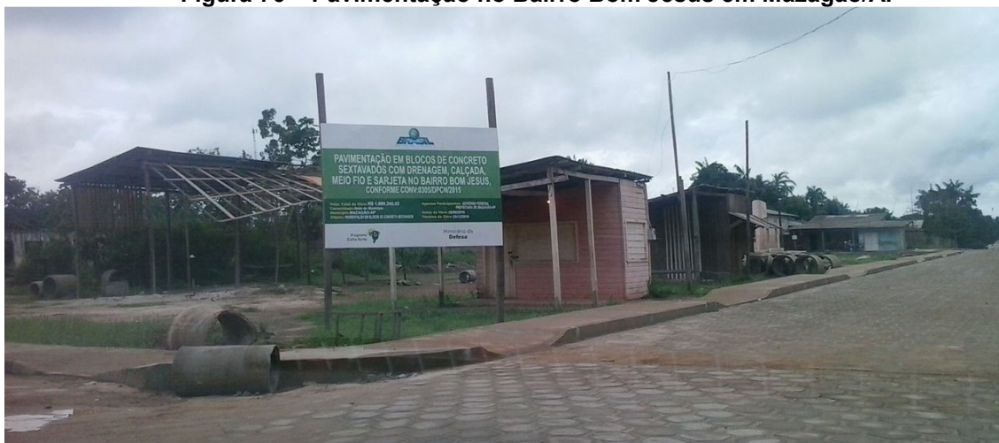
Figura 76 – Pavimentação no Bairro Bom Jesus em Mazagão/AP
