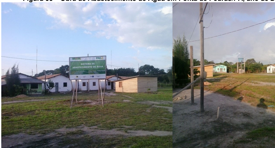
Figura 55 – Obra de Abastecimento de Água em Ponta de Pedras/PA, ano de 2012.
