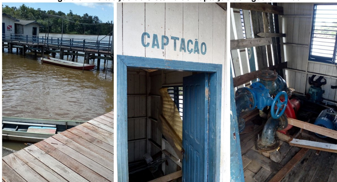
Figura 54 – Situação do Sistema de Captação de Água em Afuá/PA.
