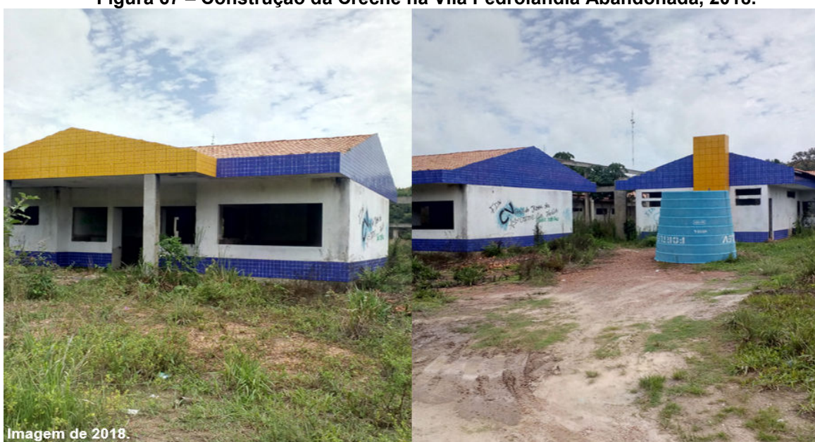
Figura 67 – Construção da Creche na Vila Pedrolândia Abandonada, 2018.
