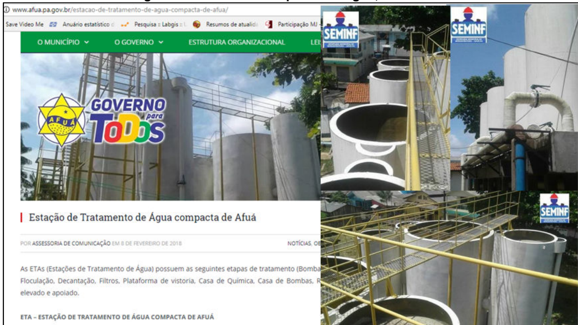
Figura 70 – Sistema Compacto de Água, em Afuá/PA.
