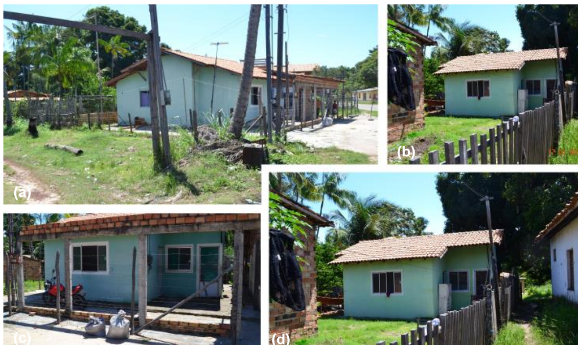
Figura 88: Casas do MCMV- Entidades em Vila de Mangabeiras (a, b, c, d).
