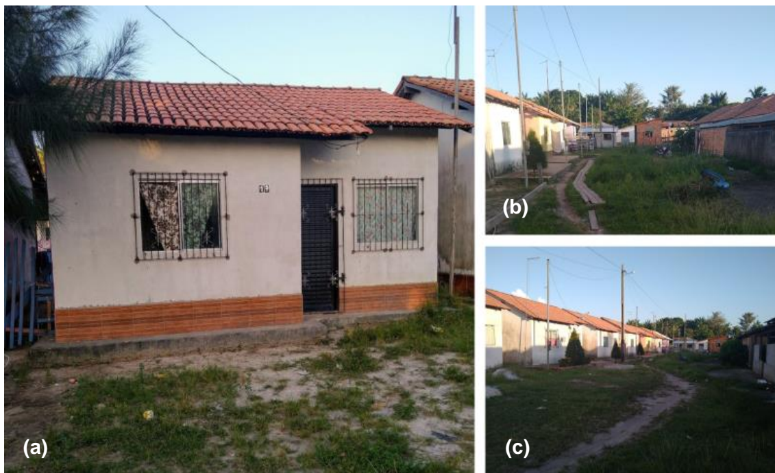
Figura 78: Ruas do conjunto habitacional Rita Gabriela e estruturas das casas (a,b,c).
