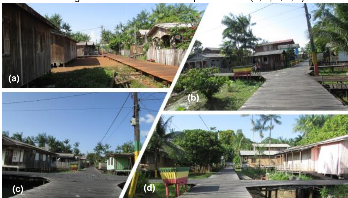
Figura 32: Ruas do Bairro Capim Marinho (a, b, c, d, e).
