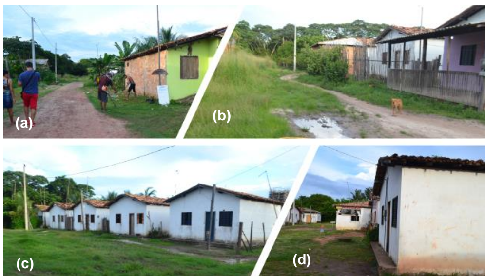
Figura 69: Ruas sem pavimentação na Vila Pedrolândia (a, b, c, d)
