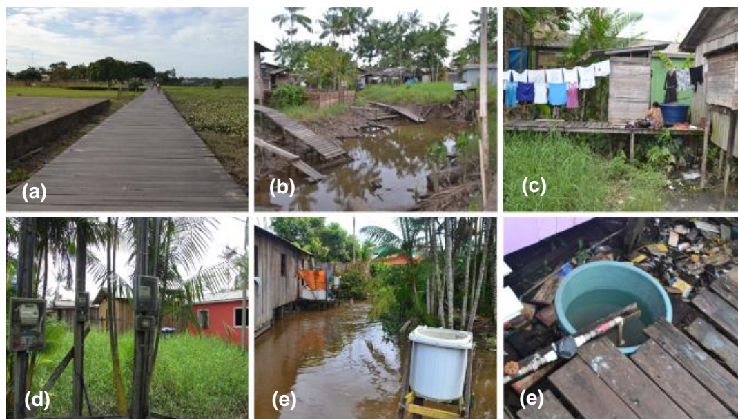
Figura 30: Infraestrutura e precariedades do Bairro Capim Marinho (a, b, c, d, e)
