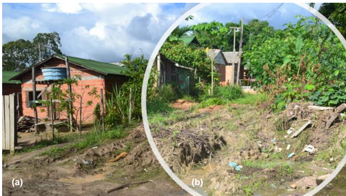
Figura 55: Precariedade do Local de construção das casas do MCMV de Mazagão (a, b) AP.
