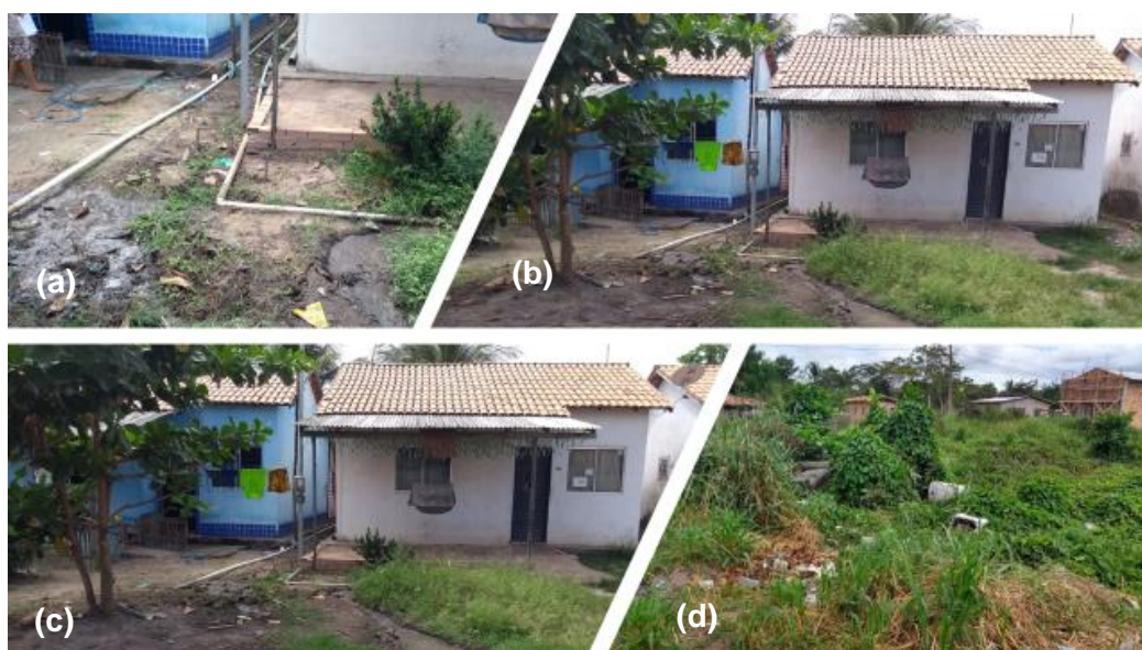
Figura 80: Esgoto lançado nas ruas do conjunto Rita Gabriela (a, b, c, d).
