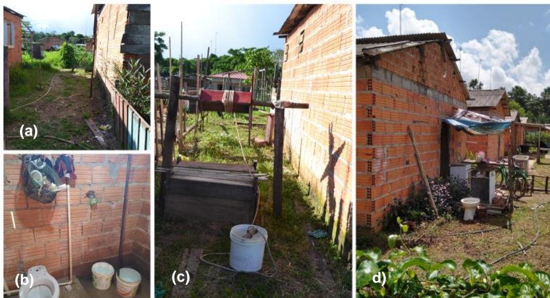
Figura 56: Precariedade do Local de construção das casas do MCMV de Mazagão, (a, b, c), AP.
