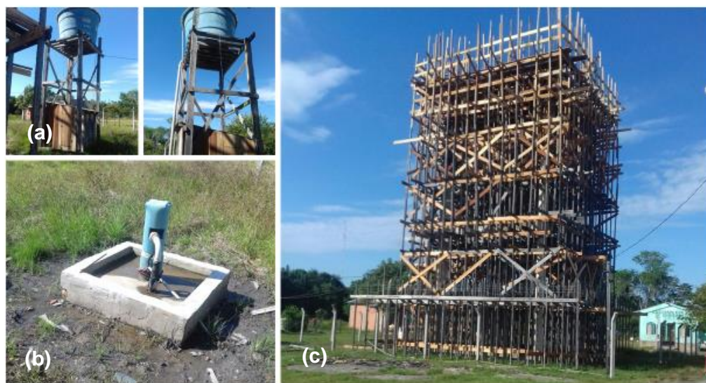
Figura 73: Obras paralisadas na caixa d'água da Vila de Pedrolândia (a, b, c ).
