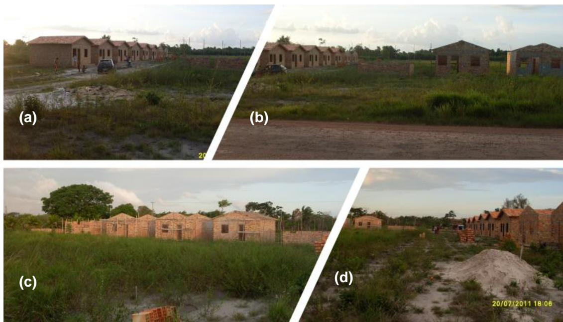
Figura 61: Casas inacabadas do MCMV de Ponta de Pedras, Vila Pedrolândia (a, b, c, d,).
