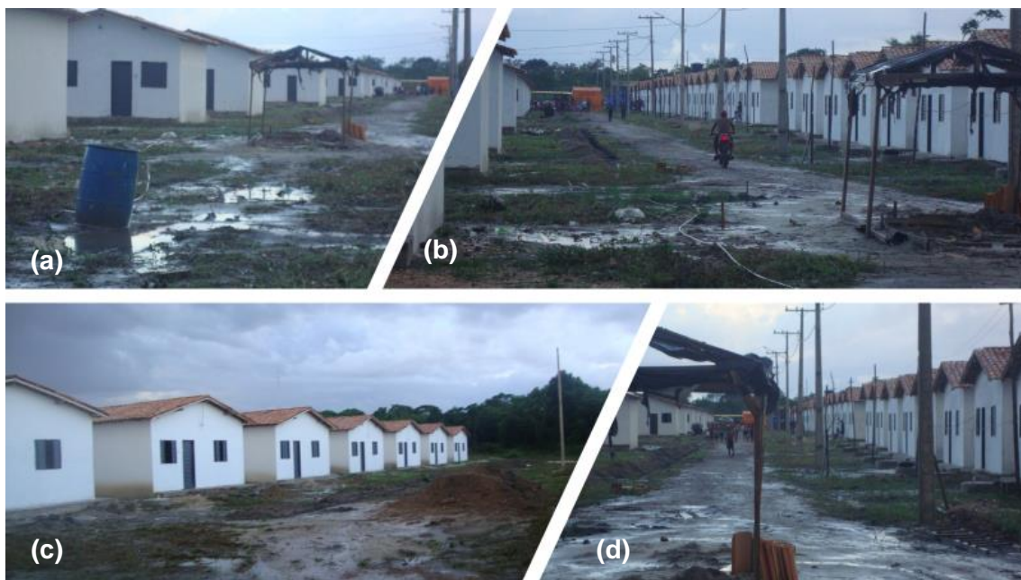
Figura 66: Canteiro de obras do programa MCMV de Vila Pedrolândia (a, b, c, d)
